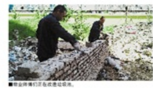
物业处师傅正在改造垃圾池。
