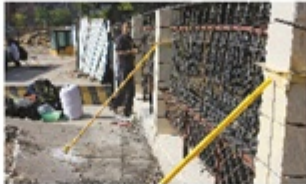
各物业处物业工作人员正在对墙体进行加固。
